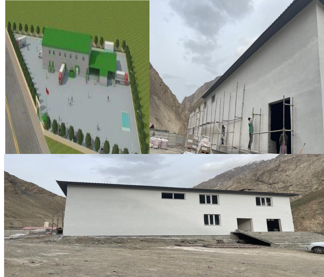
BÜYÜK ÖLÇEKLİ MODERN MEZBAHANE YAPIM İŞİ
