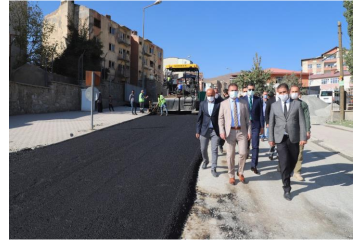
BİTÜMLÜ SICAK ASFALT YAPIMI
