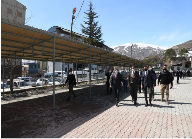
HALK PAZARI YAPIM İŞİ
