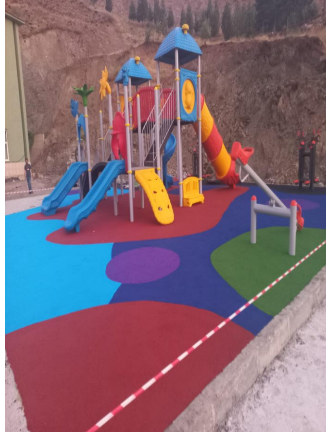
SÜMBÜL MAHALLESİ PARK YAPIM İŞİ
